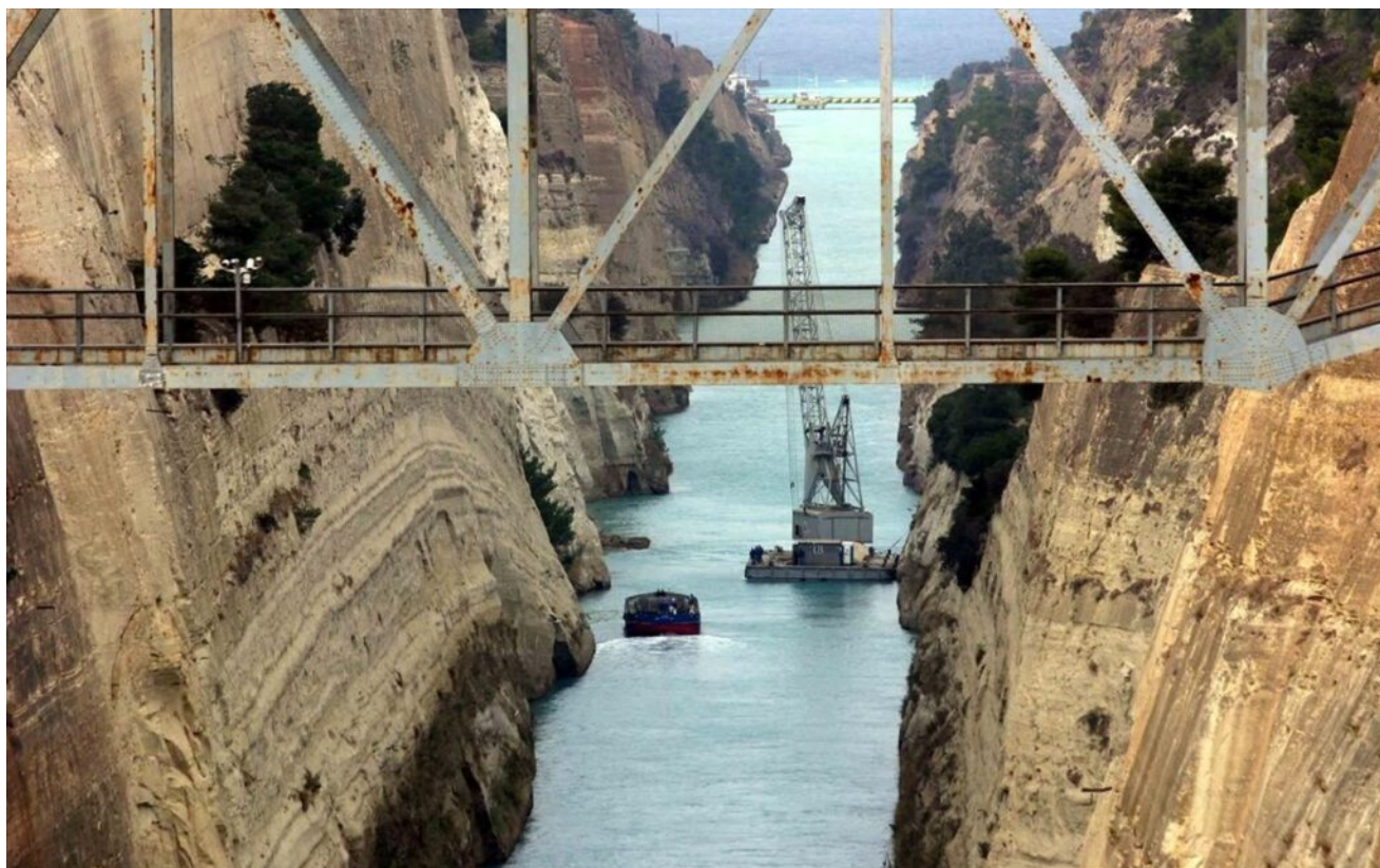
Διώρυγα Κορίνθου : έναρξη των εργασιών αποκατάστασης
